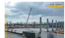
Будівельники монтують металевий каркас одноповерхівки. Вже готові обидві чахи басейнів. Їх розділятимемо прозора стіна. Опалюватимемо приміщення сучасна та енергоощадна електрична котельня. Її зведуть поруч.
